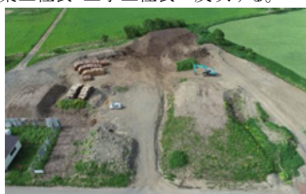
図 2.4 土砂仮置き場空撮
