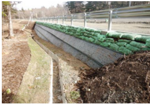
図 2.2 現地状況確認
