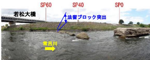
図 3.2 若松大橋下流左岸護岸状況
