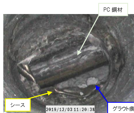
写真3.1 グループ1(9径間 G2桁 C3(起点))の削孔状況
