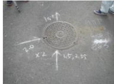
写真 2.4 地表物オフセット測量状況
