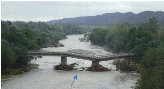
写真1.1 流木集積による橋梁破損状況(芽室川)
