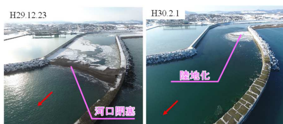
写真 3.3 上流左岸側の陸地化（閉塞②・閉塞解消②）
