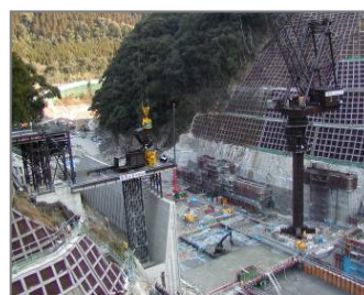
写真2 アースカラー塗装のクレーン
