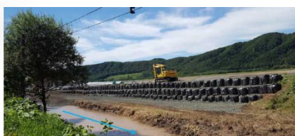
写真 5.1 大型土のう積み 設置例
