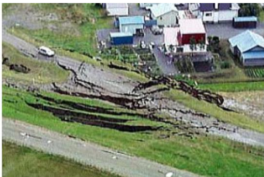
写真 1.1 十勝沖地震（平成 15 年）堤防被災状況
