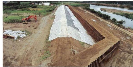
写真 4.1 鋼矢板二重締切(川表)災害時設置事例
