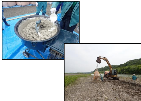
写真 3.4 トレーサー材の作成状況(上段)と設置状況(下段)
