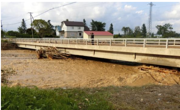
写真 1.1 洪水時に想定される状況
