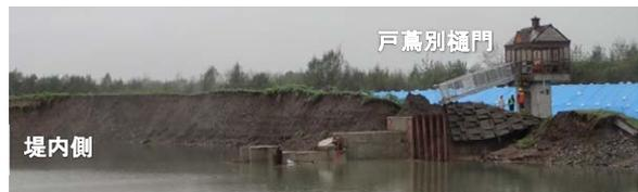
写真 4.3 中戸蔦築堤の破堤箇所 (H28/9/5 撮影)
