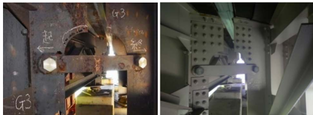
写真 1.2 補修前⇒補修後
