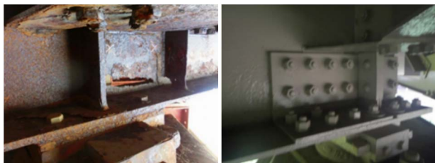
写真 1.3 補修前⇒補修後
