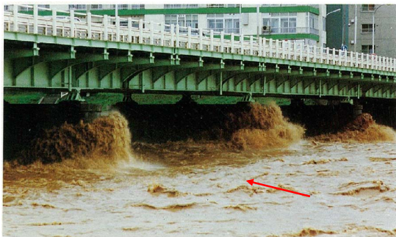
図 2.3 出水時の状況（S56. 8. 23 9:00 幌平橋）
