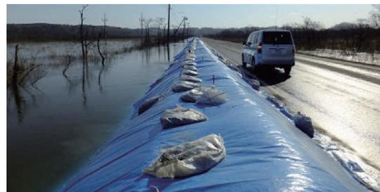
写真 4.1 緊急対策による越流の防止
