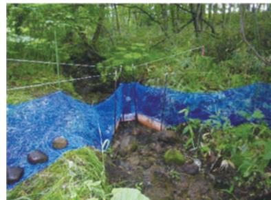
写真3.2 移動防止用ネットの設置状況
