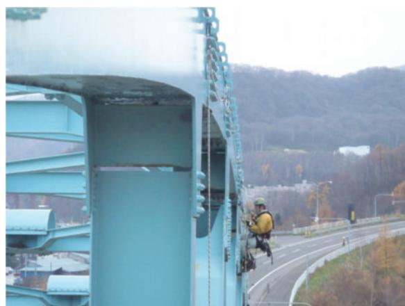
写真 3.3 ボルトの打音点検調査状況
