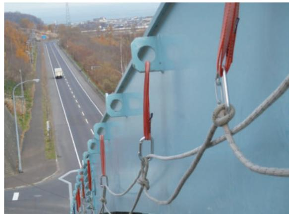
写真 3.2 アプローチラインの構築状況
