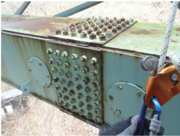
写真 3.4 ハンドホールのボルト打音点検調査状況
