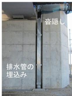
写真 4.2 排水管埋込み
