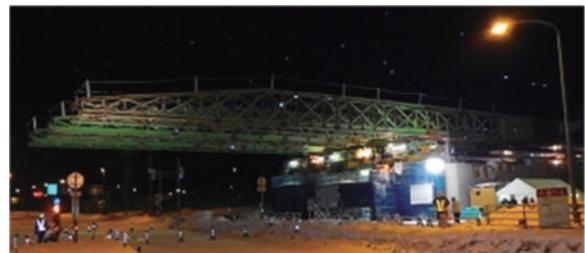
写真 5.1 函館 IC 橋送出し架設状況
