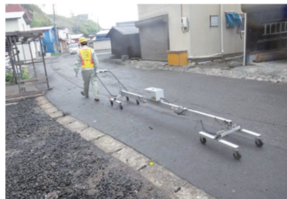
写真 2.1 プロフィールメータ（縦断）測定状況
