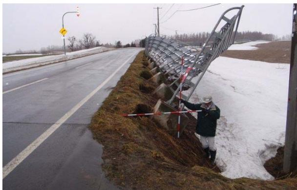
図-1 融雪災害による防雪柵の倒壊
