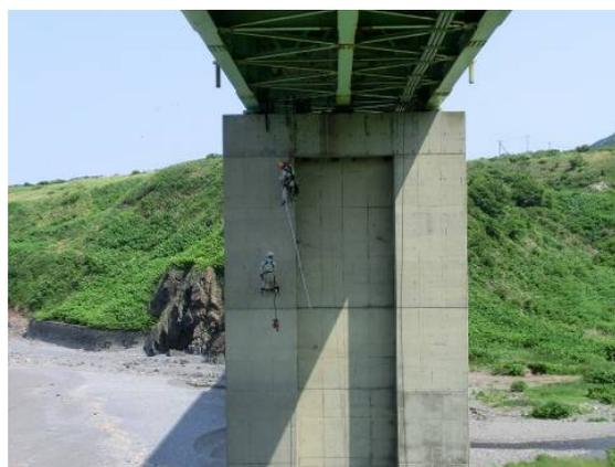
図-1 橋脚のクライミング調査事例写真
