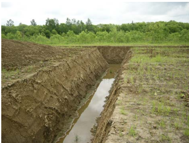
写真-1 トレンチ排水
