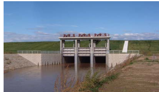
図-11 チェーン式開閉機の取付状況
