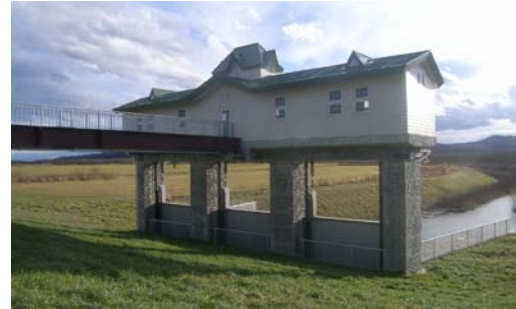
図-12 完成した上幌岡締切樋門(平成14年)
