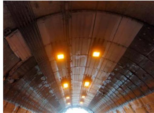
図 3.1 照明・ケーブルが添架され面導水が漸続する坑内
