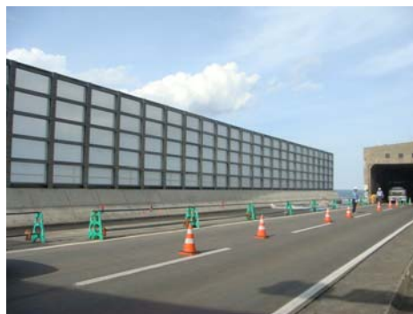
写真-4 現地完成状況
