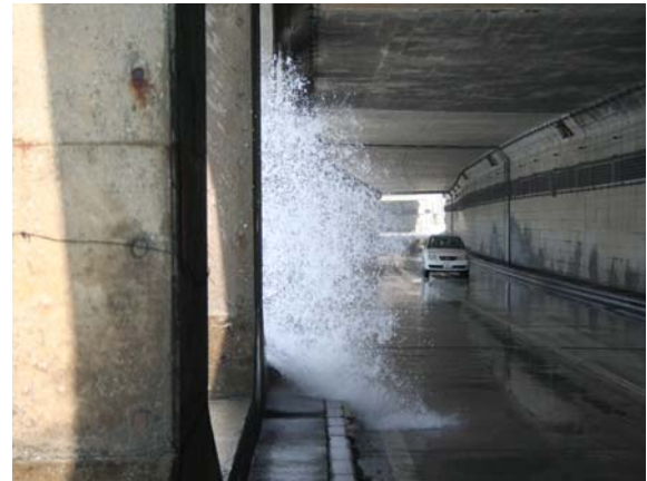
写真-2 覆道開口部からの越波状況
