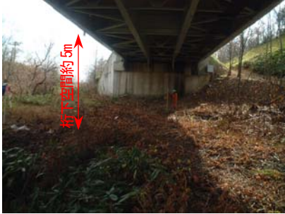
写真-3 丸松跨線橋の桁下状況
