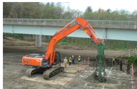
写真-5 TMM工法の施工状況
