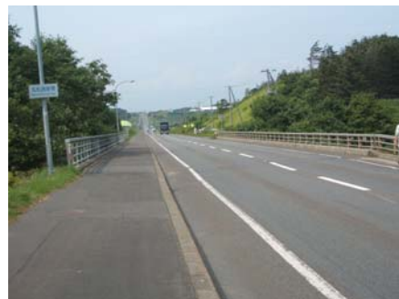
写真-1 丸松跨線橋付近の現道線形
