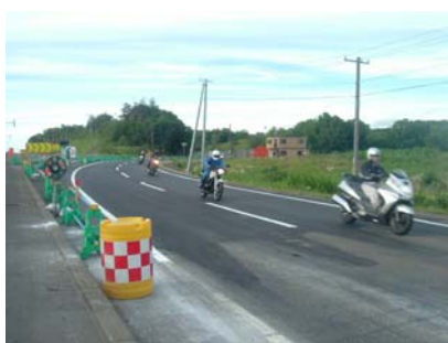
写真-4 供用中の迂回路
