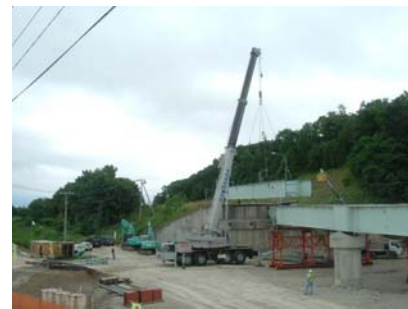
写真-6 桁撤去施工状況
