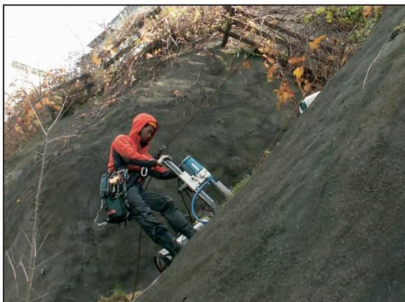
写真-11 モルタル吹付け法面におけるコアリング事例
