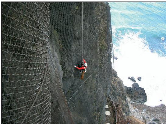
写真-1 急崖斜面におけるクライミング調査状況
