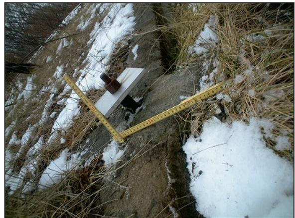
写真-10 ロックボルトの浮き上がり状況
