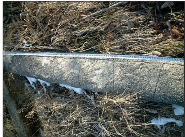
写真-9 現場吹付け法枠に発生したクラックの状況
