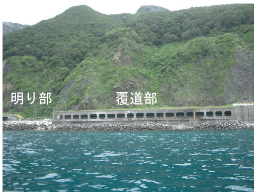
写真-1.1 実験箇所の状況
