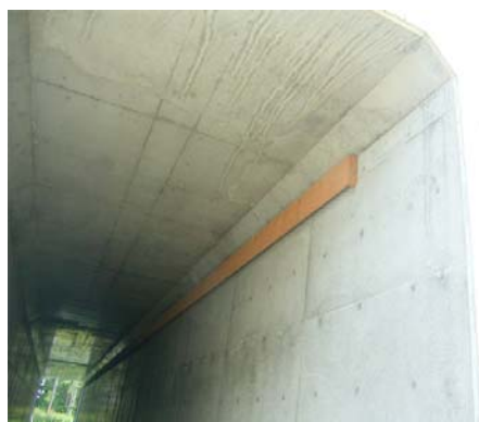
写真-3 エコボックスカルバート側面に取り付けられたバットボックス
