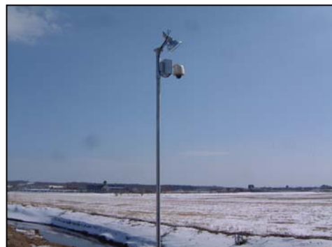
写真－２．川裏カメラ設置状況
