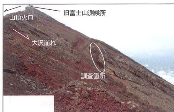
写真-7 大沢崩れの調査実施箇所 (写真は 大沢崩れ 右岸より撮影)
