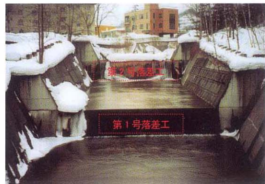
写真一1 既設落差工の前景
