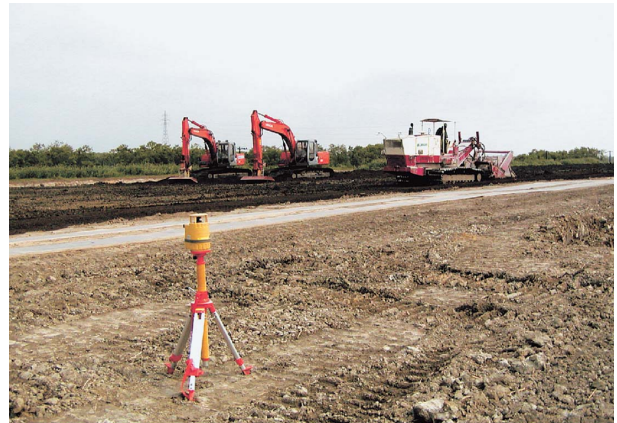
写真-11 本施工状況
