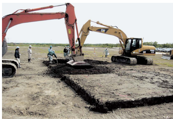
写真-9 現地試験例-2 (1材料搬入)
