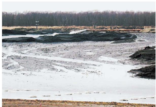
写真-2 排泥状況
