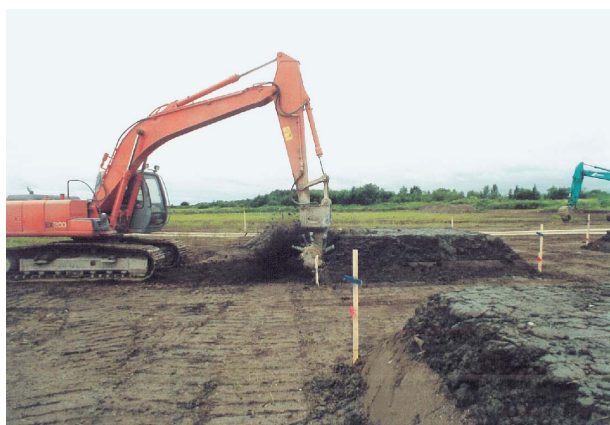
写真-8 現地試験例-1 (2材料搬入)
