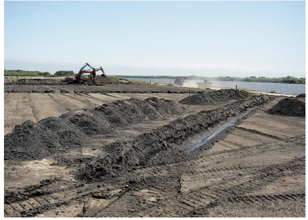
写真-13 トレンチ排水処理
