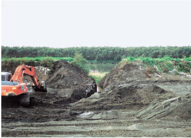
写真-12 枠堤開削
