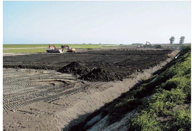
写真-10 本施工ヤード全景
