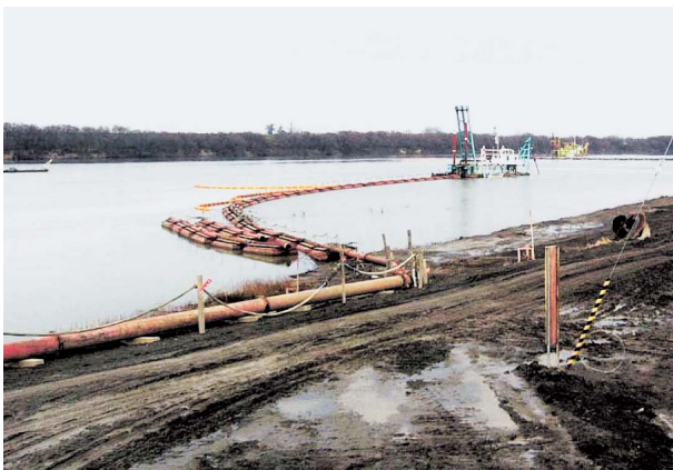
写真-1 浚渫状況
