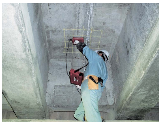
写真-4 鉄筋探査状況
