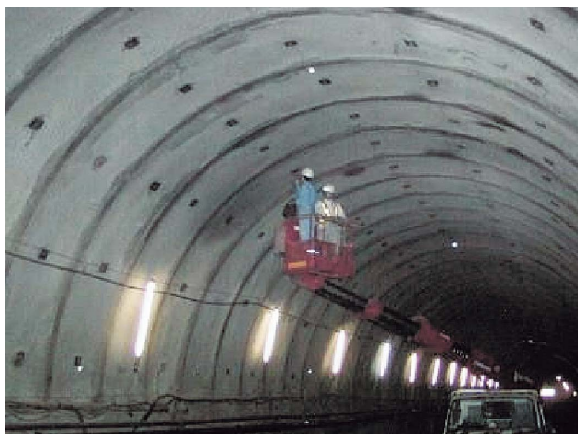
写真-2 トンネルロックボルト測定状況
