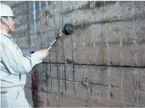
写真-10 調査状況
