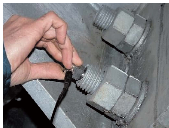
写真-1 アンカーボルト測定状況
