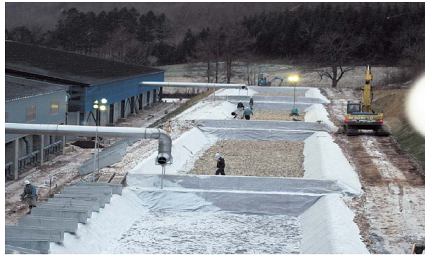
写真-2 土壌脱臭装置施工状況
