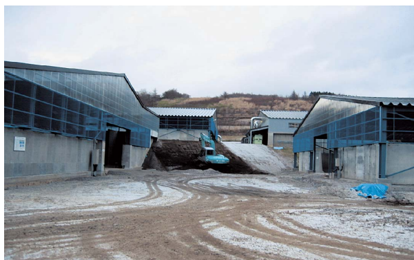
写真-1 施設全体(各発酵棟)
