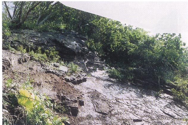
写真 3 平面型の崩落が懸念される岩盤斜面
