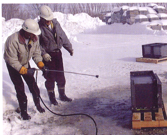
写真4 グリーンカット処理状況
