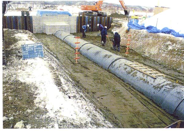
写真-2 施工時（管の埋戻し状況）
