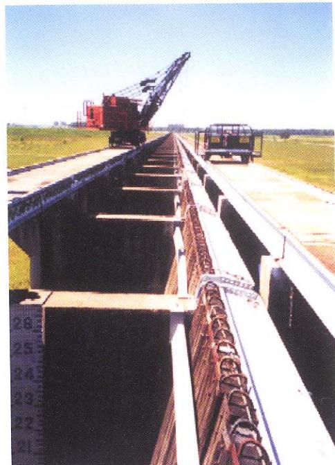
写真13 Bonnet Carre Spillway のゲート
