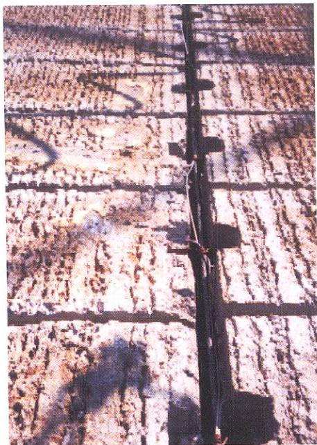
写真12 コンクリートマットの接合部
