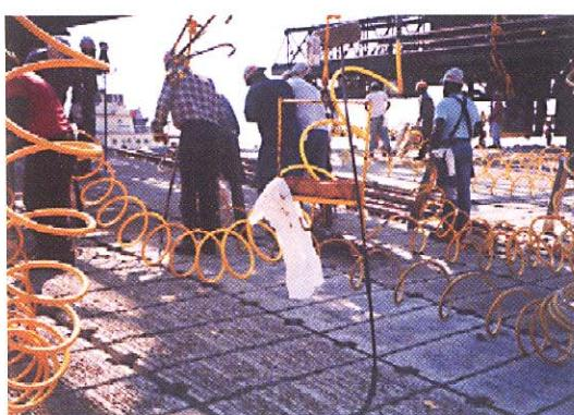
写真11 コンクリートマットの接続作業
