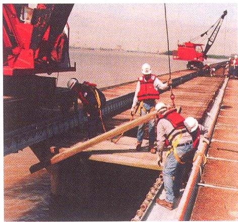
写真16 Bonnet Carré Spillway のゲート作業
