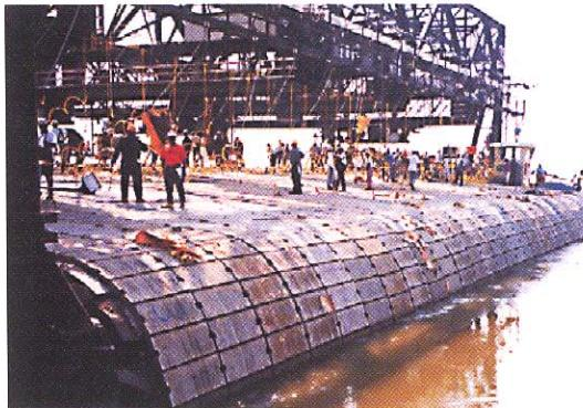
写真10 コンクリートマットの設置
