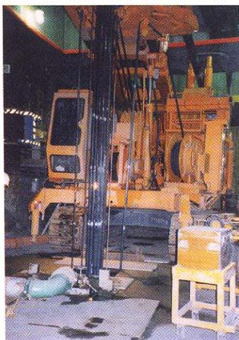
写真3-6 地中連続壁の施工
