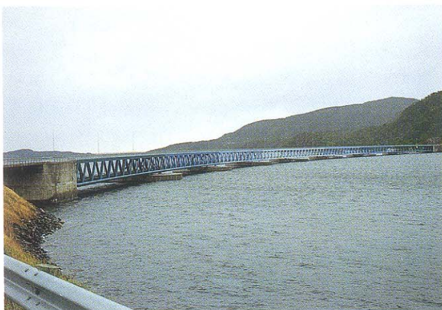
橋脚が全て浮き基礎のベルヴィン橋
