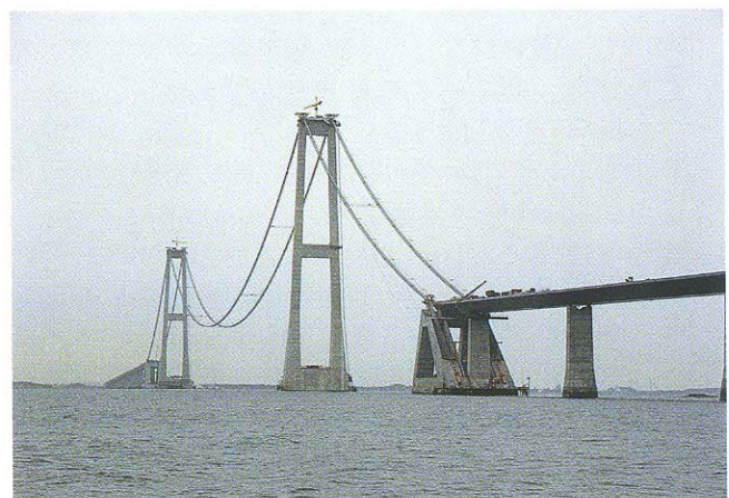
グレートベルト・リンクのイーストブリッジ 完成すれば世界最長支間 L=1,624\text{m}
