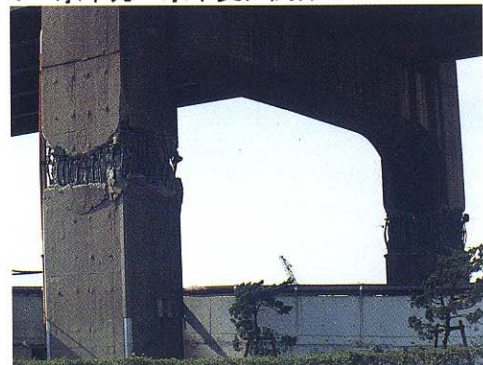
写真-5 ラーメン橋脚の塑性ヒンジ
