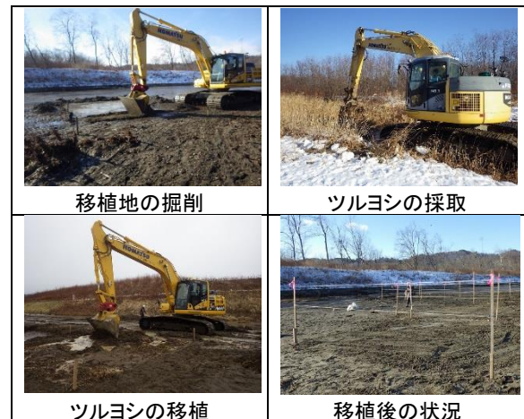
写真 4.1 工法 A の実施状況
