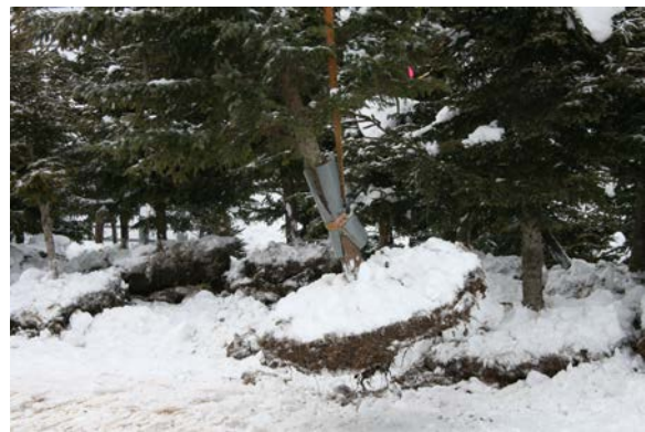
写真-4 凍土方式による運搬状況(吊り下げ)
