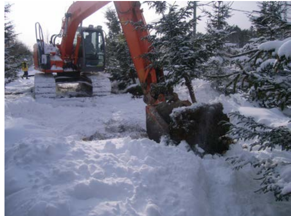
写真-3 凍土方式による掘り取り状況
