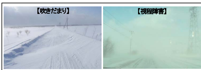
図-1 吹きだまり・視程障害の発生状況
