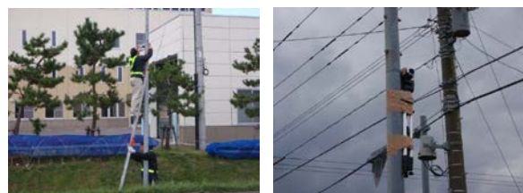
図-7 調査状況図及びビデオカメラ設置状況写真
