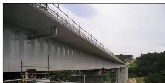
写真1 主桁・床版架設中
