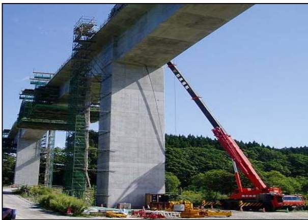
写真3 片持架設施工中
