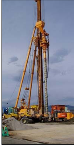
写真2 杭打設状況全景
