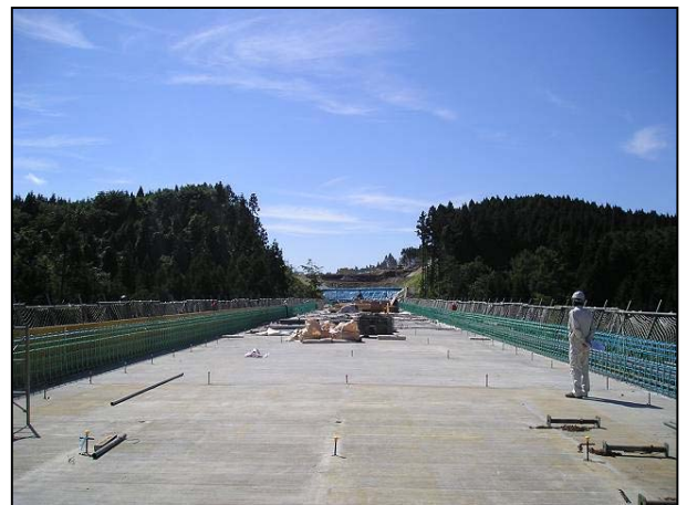
写真5 橋面工施工中
